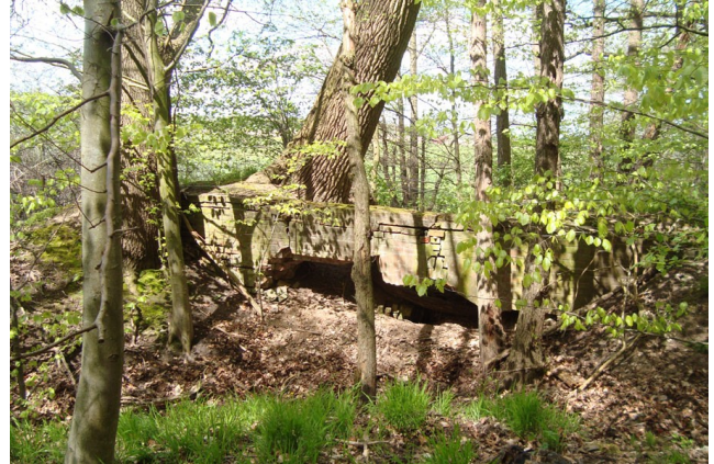
Brückentorso wenige Meter weiter
